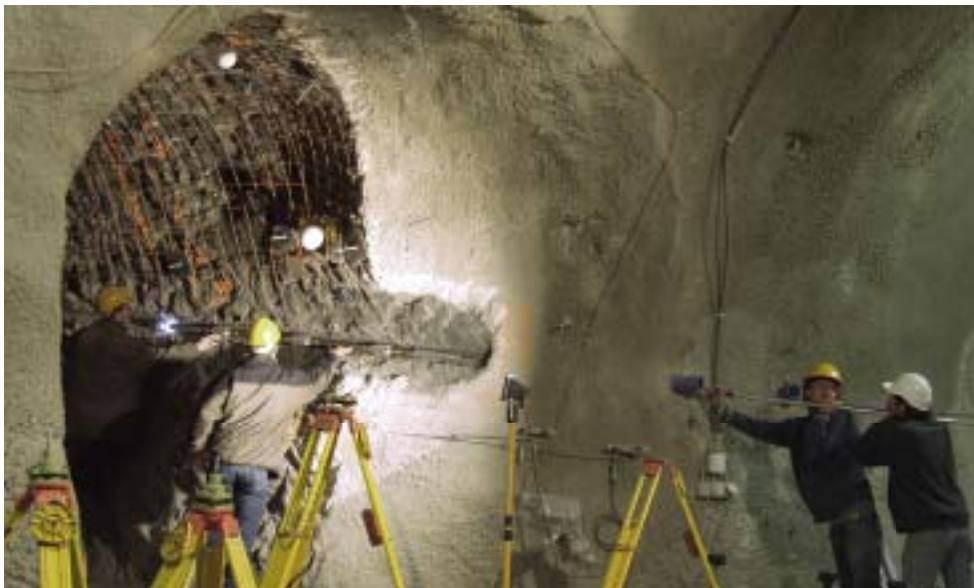
Im Teststollen des Mont Terri messen die Forscher mit einer optischen TelevIEWer-Sonde, ob und wie der Fels auf «Stress» reagiert. Die Schichtorientierung des Felsens wird mit einem Geologenkompass erhoben (kleines Bild).
